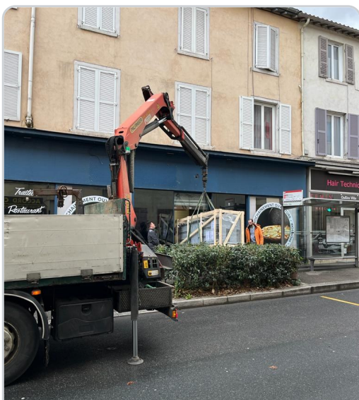
CAMION-GRUE · ACCÈS CENTRE-VILLE
