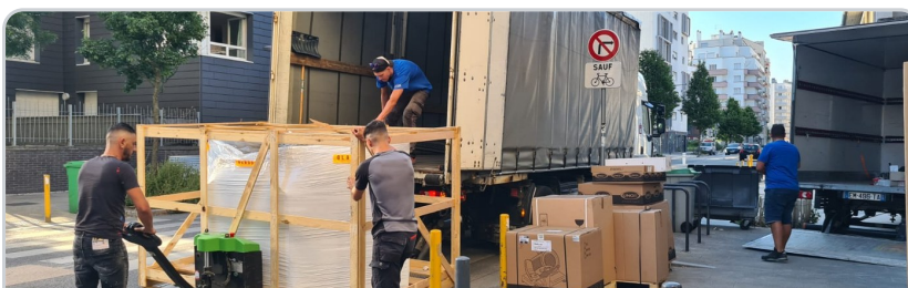
DÉCHARGEMENT SYNCHRONISÉ AVEC LES ÉQUIPES DE POSE
